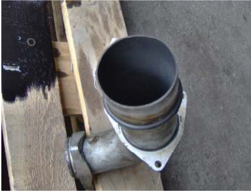
Фотографија 3 - Детаљ скинуте излазне цеви из компресора без трагова присуства уља
