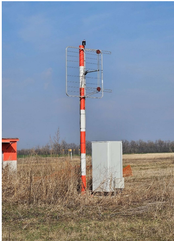
Слика 19. Приказ стуба са антенном/стуб на ком је постављена антена „Far field Monitora“ за RWY 12R пре и након удеса
