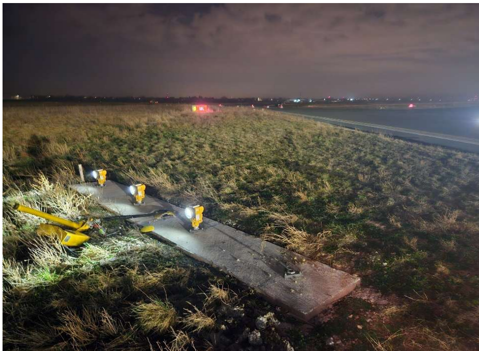
Слика 17. Оштећење система светлосног обележавања, први ред светала на око 150 метара од краја прага полетно слетне стазе
