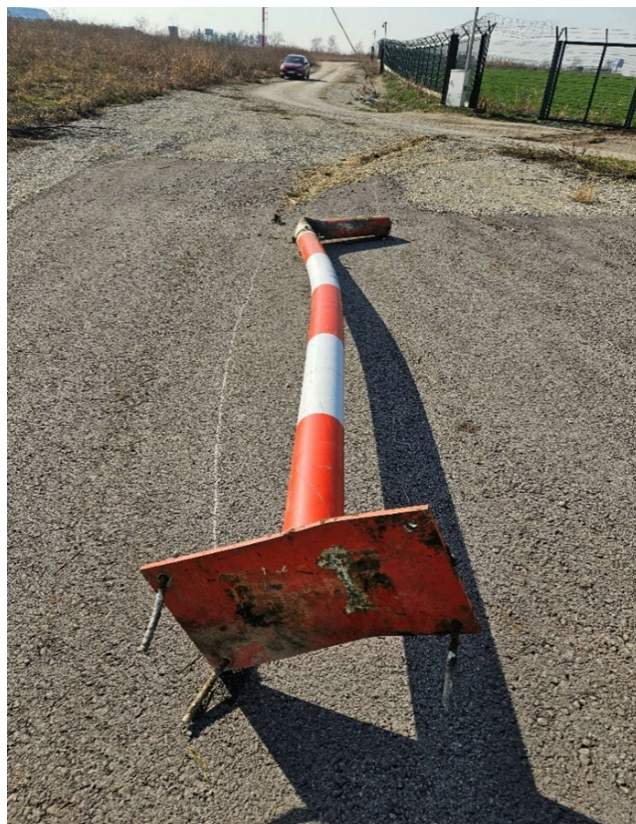
Слика 19. Приказ стуба са антенном/ стуб на ком је постављена антена „Far feeld Monitora“ за RWY 12R пре и након удеса
