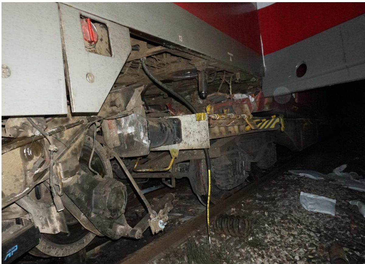
Слика 4.1.1.3: Изглед оштећења на колима број 33 68 4952 037-2
