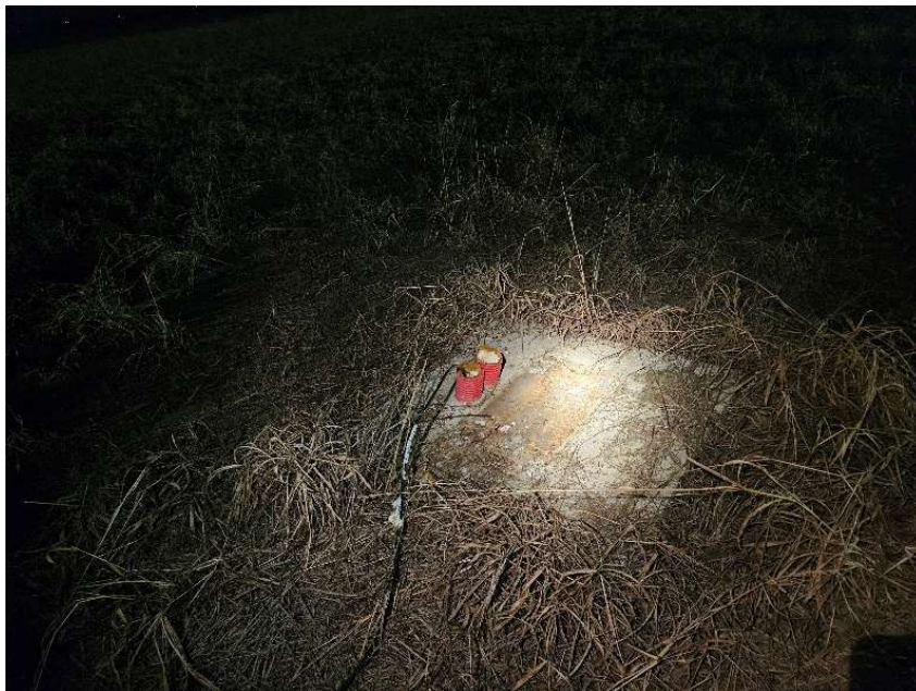
Слика 18. Темељ носача мониторингске антене „Far field Monitora“ који се налази на око 260 метара од краја прага полетно-слетне стазе
