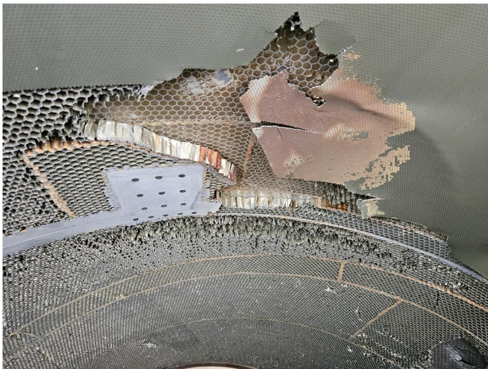
Слика 2. Оштећење саћасте структуре и унутрашње оплате контрапотисника – зона оправке шири поглед
