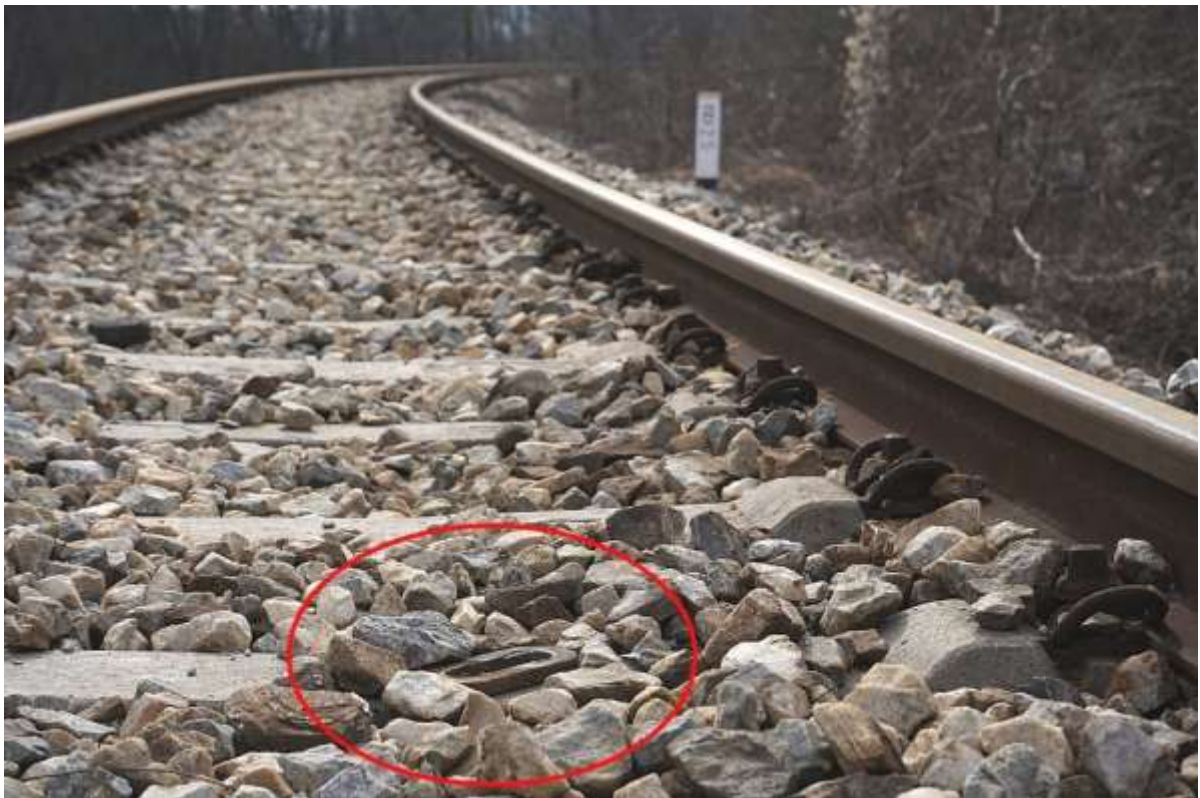
Слика 4.2.9.3: Испала карика огибљења
