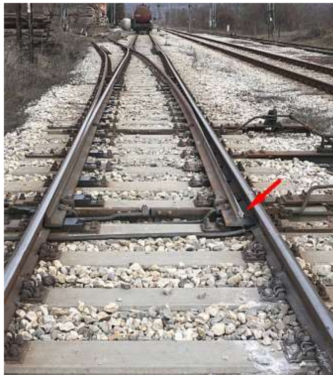
Слика 4.2.10.2: Поломљени језичак и трагови на срцишту скретнице број 4 у станици Врчин
