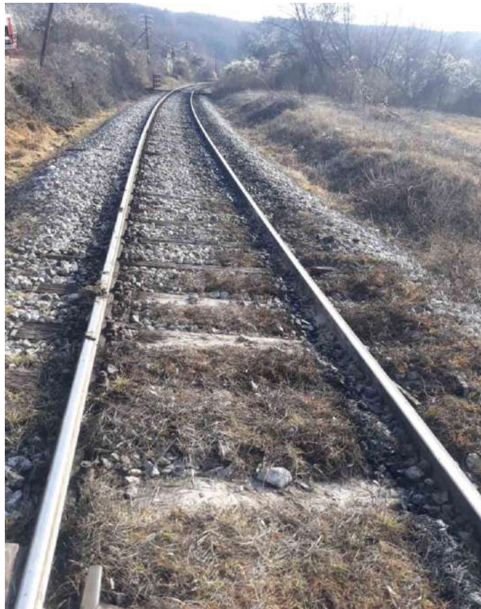
Слика 3.4.2.4: Застор од туцаника кречњачког порекла (извор: „ИЖС“ а.д.)
