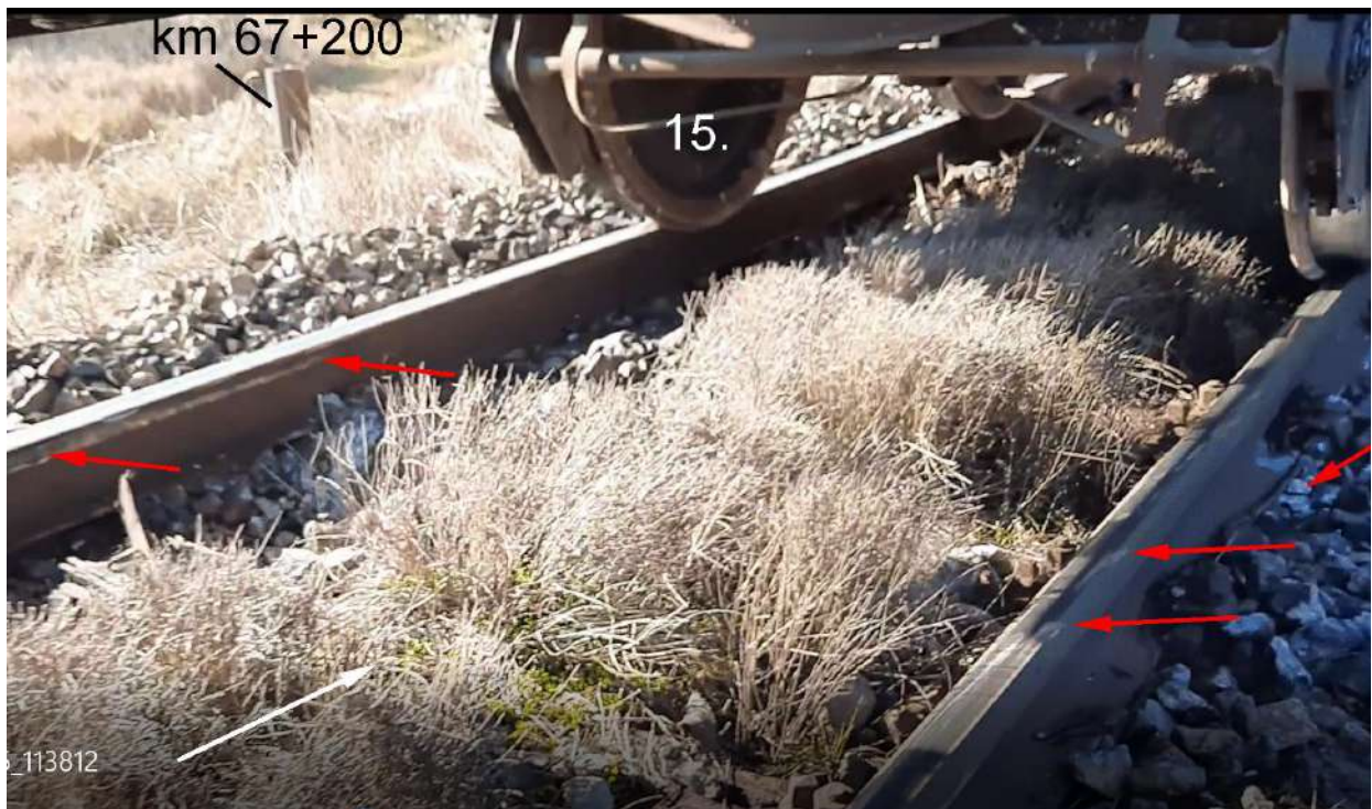
Слика 4.2.1.17: Траг исклизнућа на десној шини
