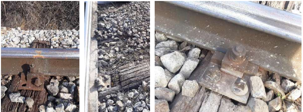
Слика 4.2.9.4: Изглед веза шина праг подложном плочом
