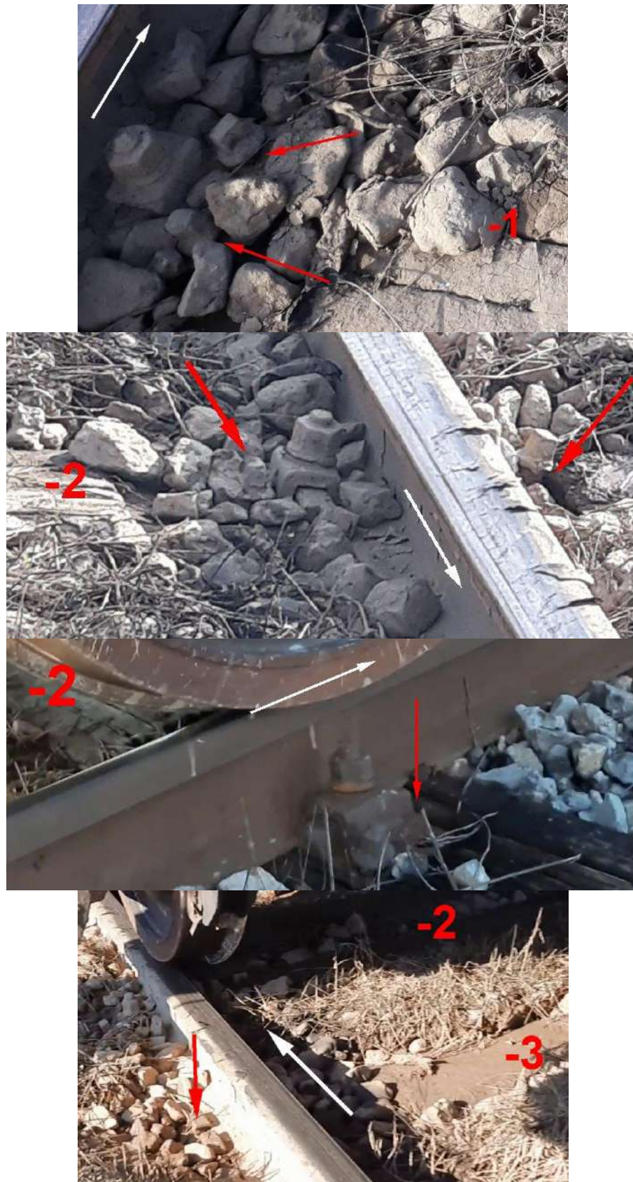
Слика 4.2.1.20: Стање причврсног прибора у зони првог упадања точка
