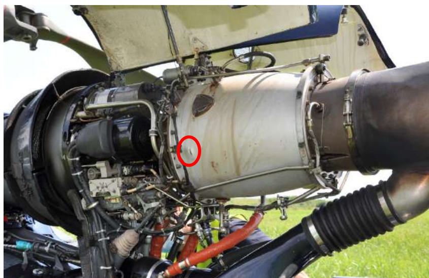
Слика 3 а. Оштећење на оплати коморе сагоревања
