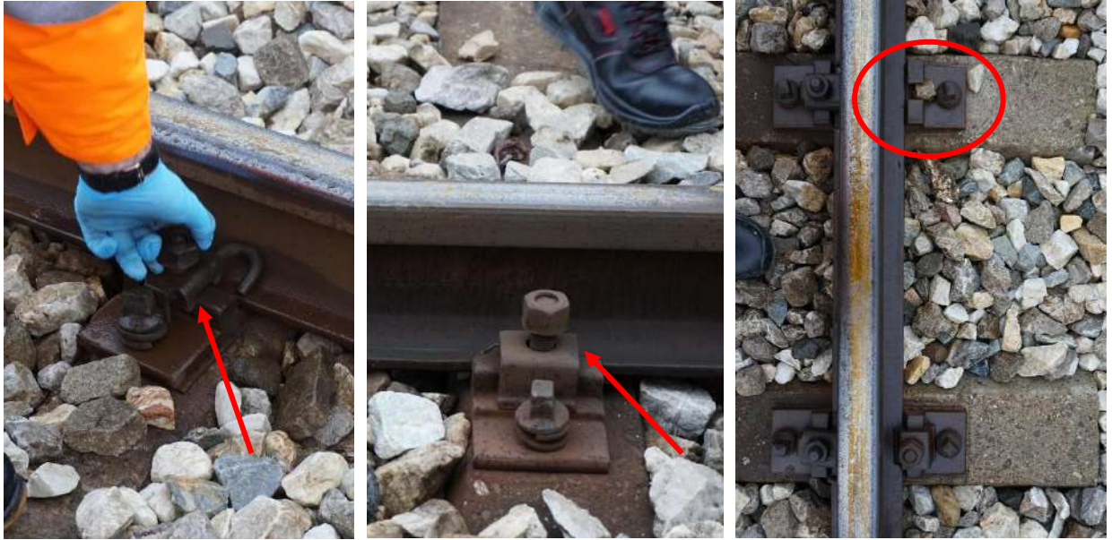
Слика 4.2.9.6: Изглед колосечног прибора у зони настанка несреће
