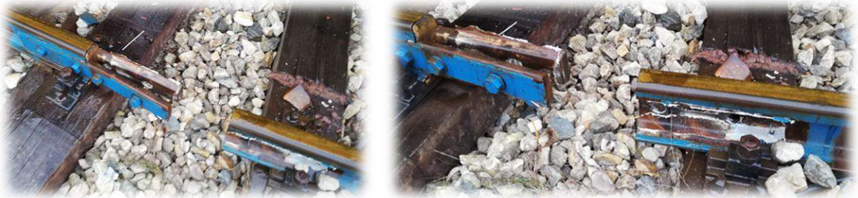
Слика 4.2.10.2: Изглед прснућа спојних вијака у изолованом саставу у km 123+660,80 (лева шина у смеру растуће стационаже левог колосека)
