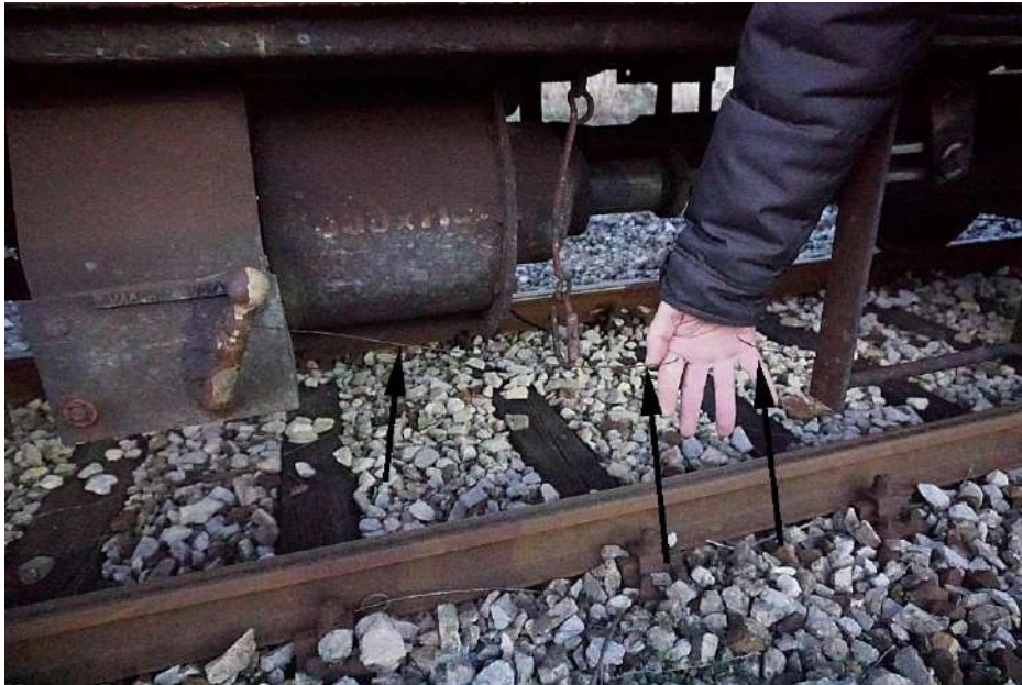
Слика 4.2.2.1: Жица којом је била фиксирана ручица G-P мењача
