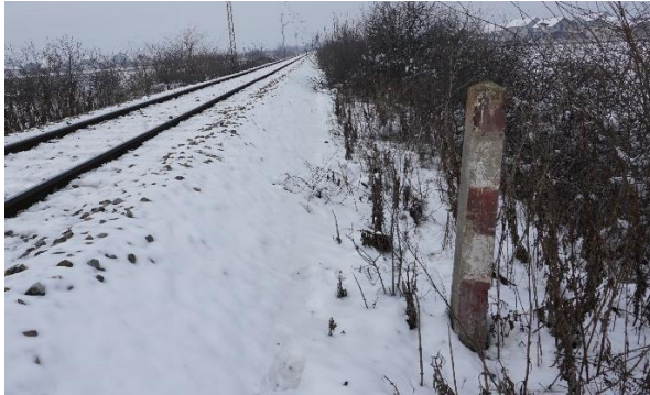
Слика 2.2.3.13: Изглед сигналне ознаке 209: „Пази, путни прелаз“ (поглед из смера укрснице Белотинце)
