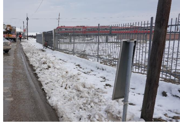
Слика 2.2.3.17: Изглед ограђеног простора (поглед из смера Доњег Међурова)
