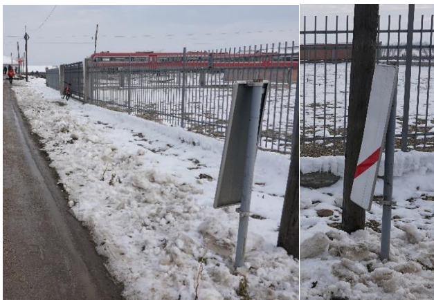
Слика 2.2.3.5: Изглед саобраћајне сигнализације (поглед из смера центра Доњег Међурова)
