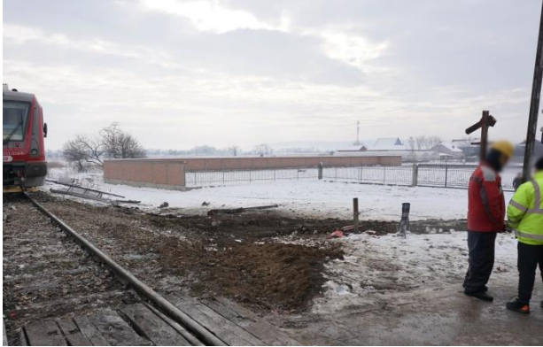
Слика 2.2.3.16: Изглед ограђеног простора (поглед из смера Ниша)
