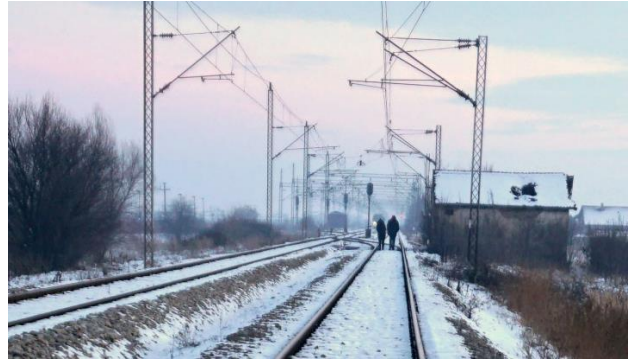
Слика 2.2.3.14: Изглед скретничког блока 1 станице Међурово (поглед из смера станице Ниш)
