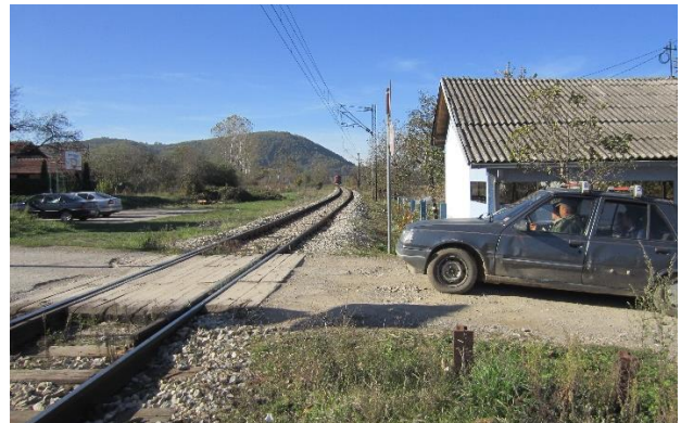
Слика 2.2.3.4: Изглед оштећења на коловозу пута
