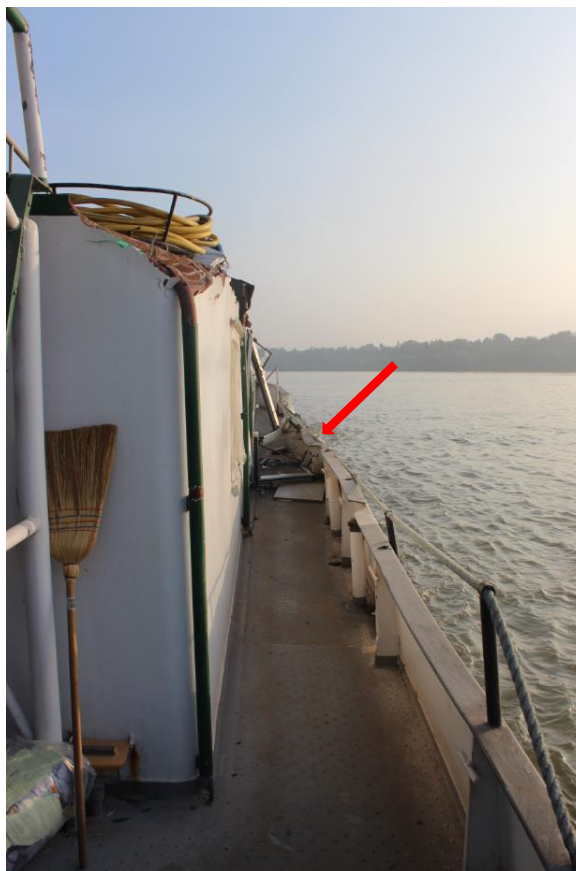
Слика 2.1.7. Оштећена и деформисана оплата палубне ограде означена је црвеном стрелицом
