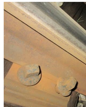
Слика 4.2.4.2: Причвршћење шине ексерима и тирфонима
