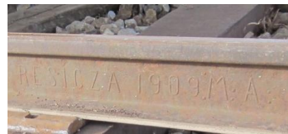
Слика 4.2.4.1: Нестандарна шина типа „C“
