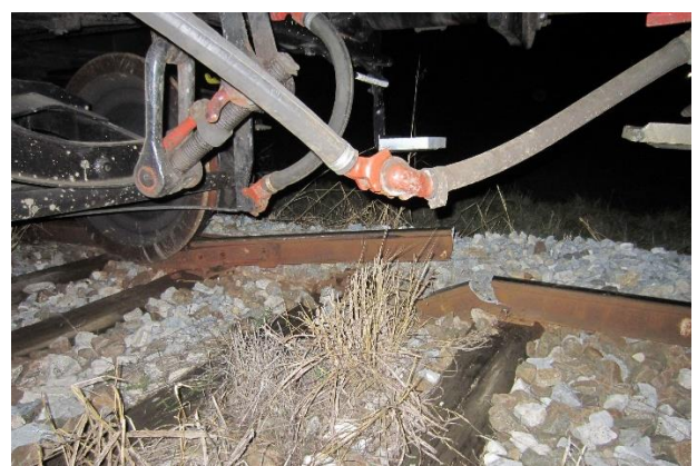
Слика 3.4.4.3: Изглед сломљене шине
