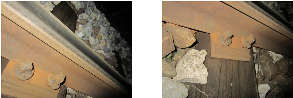
Слика 4.2.6.3: Веза шина праг подложном плочом, причвршћење тирфонима
