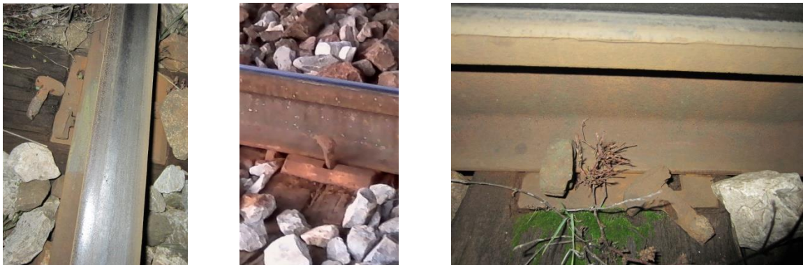
Слика 4.2.6.4: Веза шина праг подложном плочом, причвршћење колосечним ексерима
