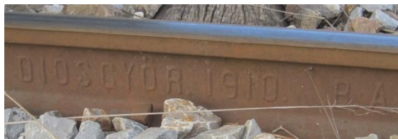
Слика 4.2.4.1: Нестандарна шина типа „C“
