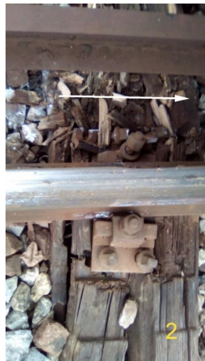
Слика 4.2.1.2: Први трагови оштећења од упалог точка на унутрашњој страни унутрашње шине
