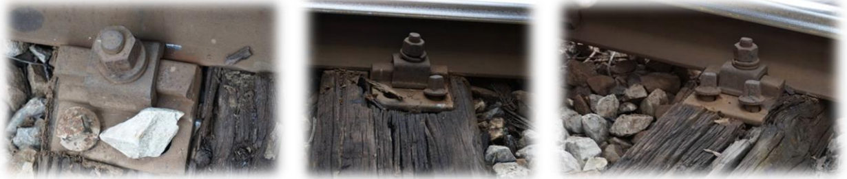
Слика 4.2.8.2: Приказ причвршћења шине тирфонима
