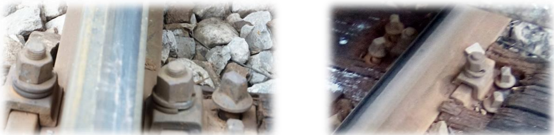
Слика 4.2.10.4: Веза шина праг подложном плочом, причвршћење тирфонима
