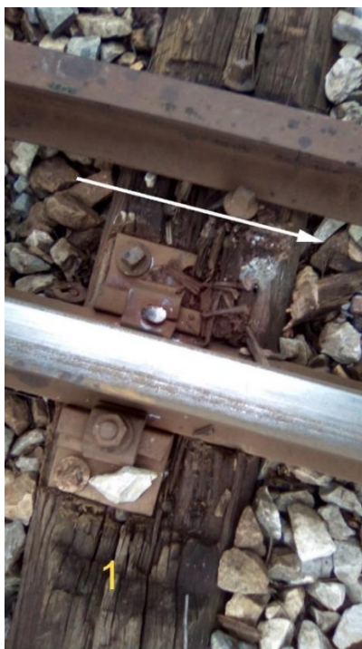
Слика 4.2.1.2: Први трагови оштећења од упалог точка на унутрашњој страни унутрашње шине
