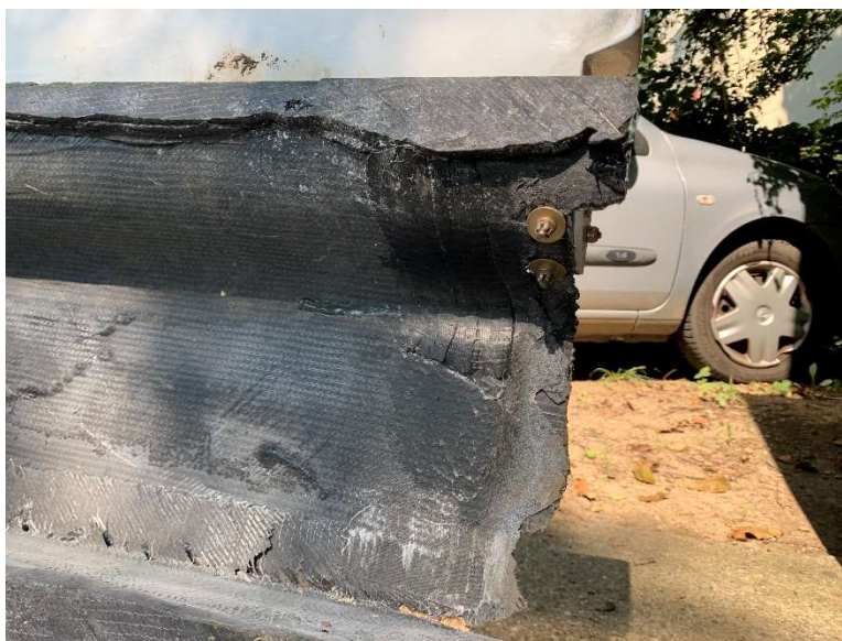
Слика 14. Терминезон левог крила са додатком крилца које је ручно постављено у позицију
